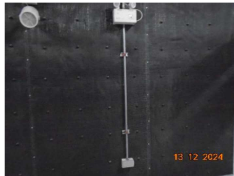
ภาพที่ 2.1-23 การติดตั้งแผ่นกันเสียง ภายในห้องเครื่องสูบน้ำ
